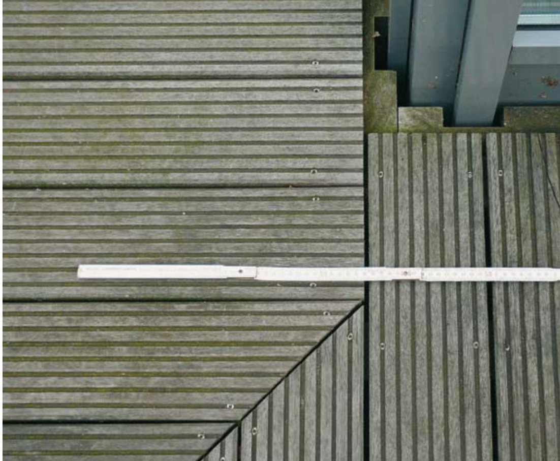
Zu schmal darf die Fuge nicht sein (oben), 6 bis 10 mm sind erforderlich (unten)
